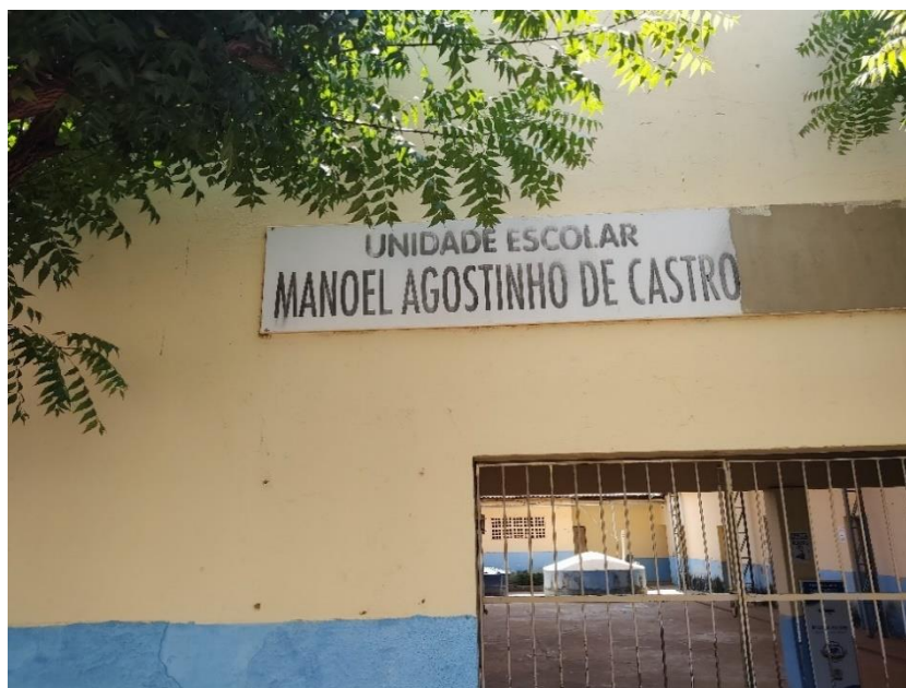
Fotografia 22. Fachada parcial da Unidade Escola Manoel Agostinho de Castro, no povoado Lajes de Pedra
