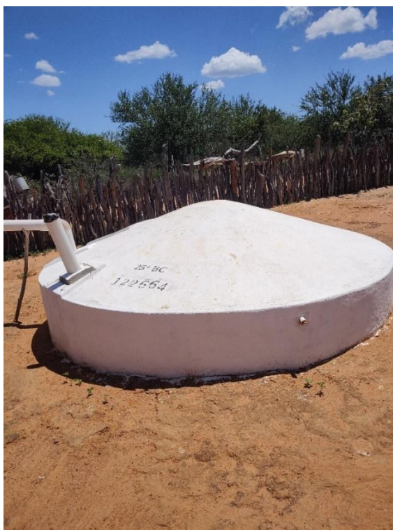
Fotografia 23. Cisterna de captação de água da chuva, localidade Lagoa
