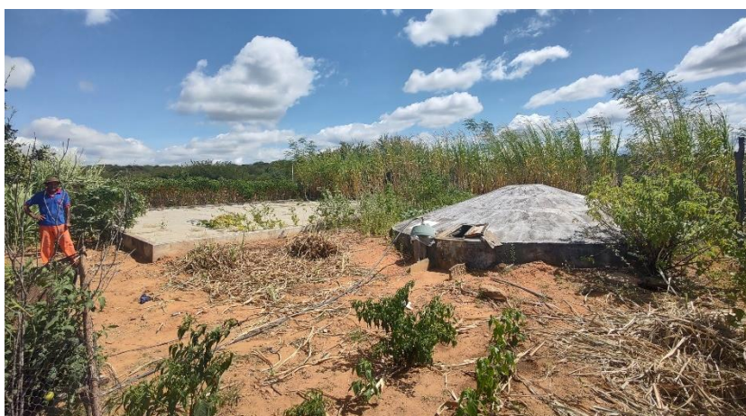
Fotografia 24. Cisterna calçadão, aos fundos de uma casa no povoado Salininha
